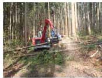
【フェラバンチャザウルスによる作業路開設】
