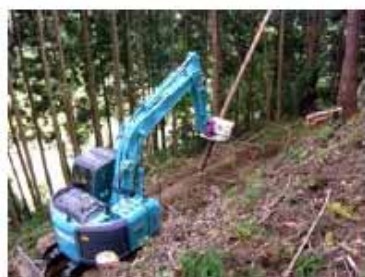
【フェラーバンチャザウルスによる作業道作設】
