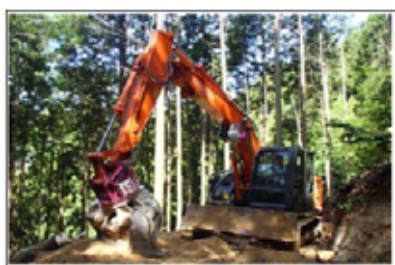
【フェラバンチャによる作業道開設】
