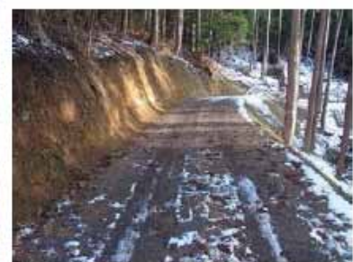
【碎石を敷きつめた作業道】
