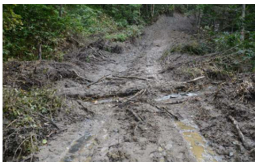
写真. 1 作業道の泥濘化
