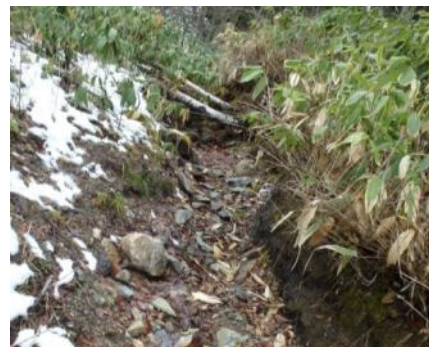
写真. 5 枯れ沢の状態
