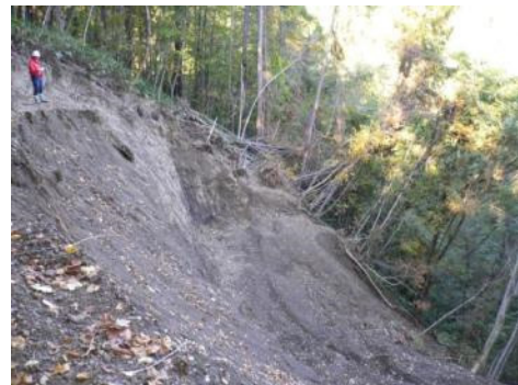
写真. 6 急傾斜地の盛土崩壊状況
