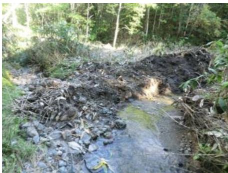
写真. 4 作業道開設にともなう河川の切り替え
