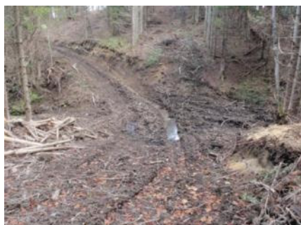
写真. 3 作業道の縦断勾配変化点
