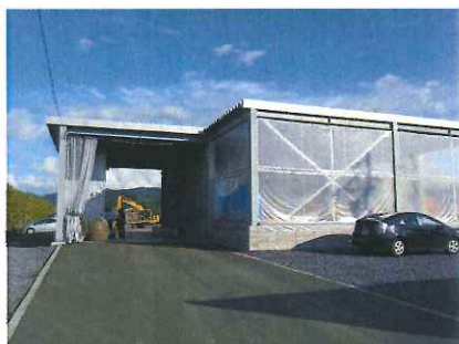
建屋（計量室、チップヤード、重機保管庫）
