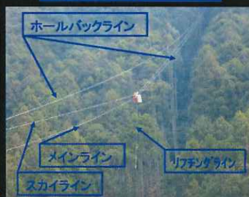
試行作業システム(現場)
