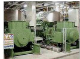
写真: ガスエンジン発電機
