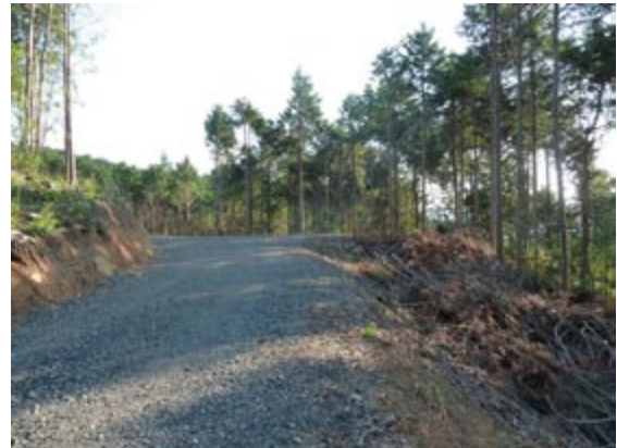
写真 5.10 林業専用道 (10 t 積みトラックが通行可能)
